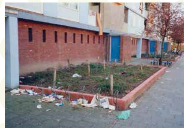
· Figuur 11: Voortuintjes bij appartementengebouw in Kanaleneiland, Utrecht.
