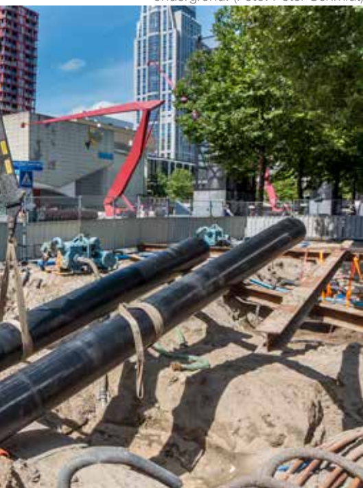
Werkzaamheden in drukke ondergrond. (Foto: Peter Schmidt)
